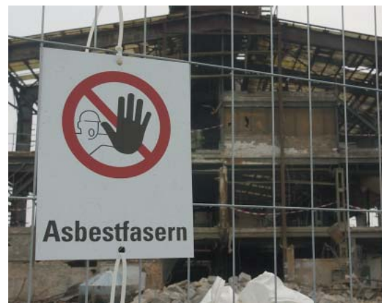
Ein Schild warnt vor Asbestfasern an einem Bauzaun vor der Zinkhütte in Hettstedt. Bisher mussten Haftpflichtversicherer zahlen, jetzt verweigern viele die Deckung von Asbestrisiken. Foto: ddp
